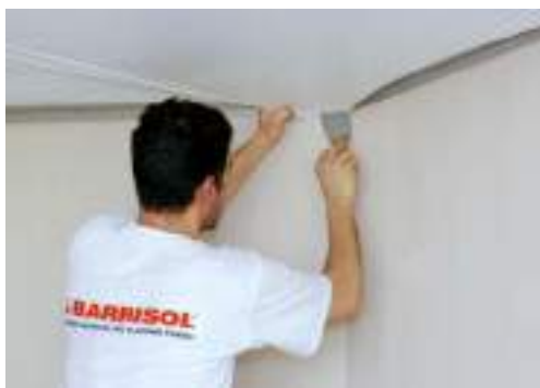
Enclenchement de la toile du plafond tendu Barrisol® dans les lisses.
