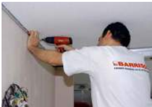
Fixation de lisses Barrisol® autour des murs à la hauteur désirée.
